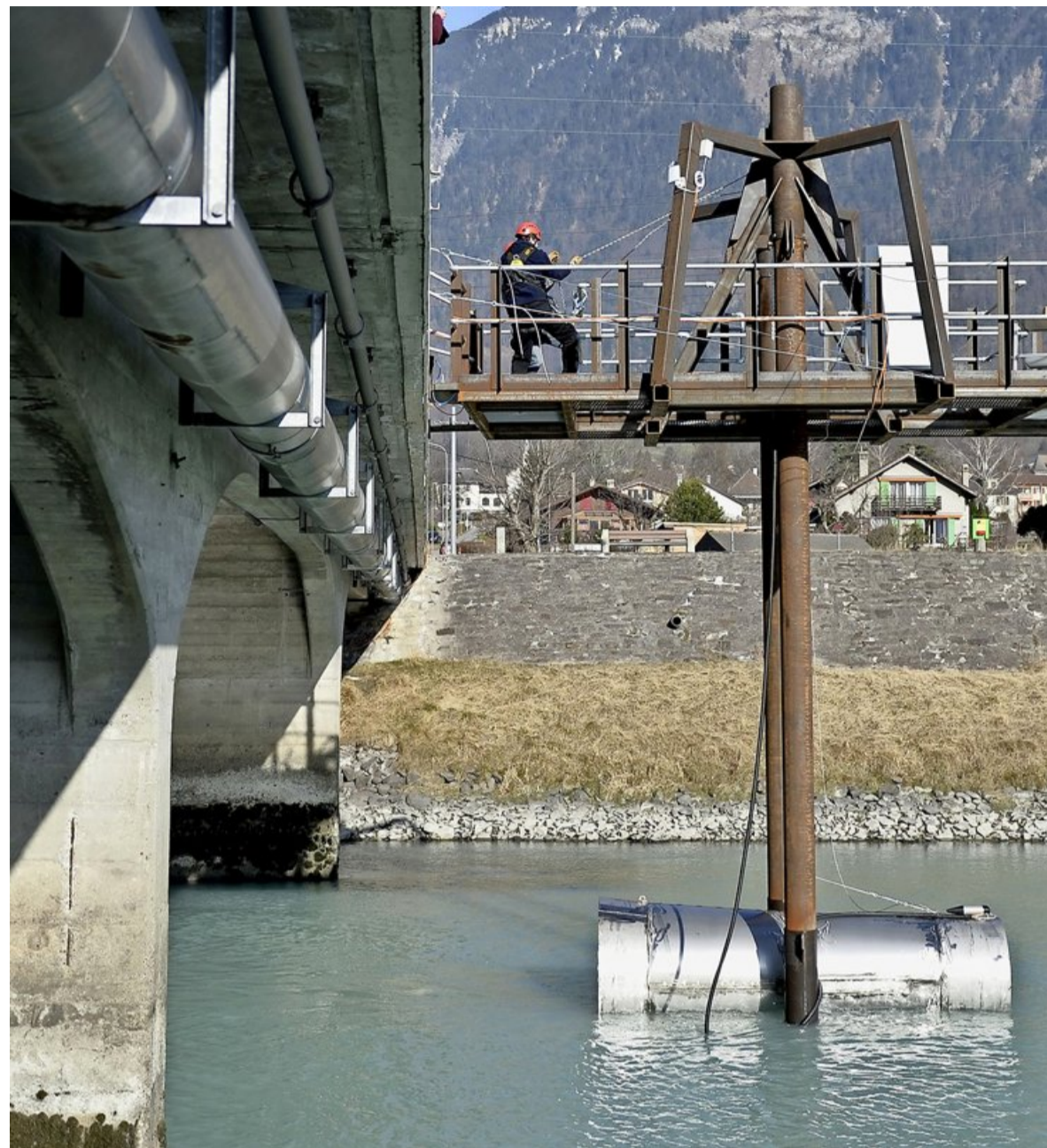
L'hydrolienne conçue par la haute école valaisanne a été mise à l'eau mardi. La phase de tests durera lesquel les concepteurs du prototype mesureront les performances de l'engin.
