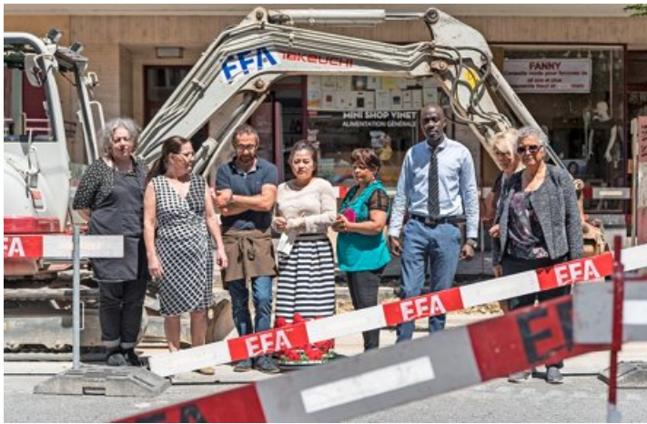
Les commerçants de l'avenue Vinet sont mécontents: le chantier leur fait perdre des clients. FLORIAN CELLA
