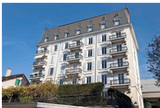
Le bâtiment est voué à la démolition dans le cadre du projet Léman 2030 des CFF.
